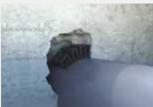
Ancrage du tube dans un mur
