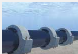
Buter les éléments de lestage d'un tube
